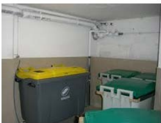
Nettoyage, désinfection des locaux à poubelles
